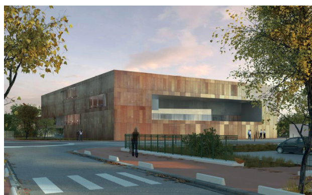
Quartier de semi-liberté et siège du service pénitentiaire d'insertion et de probation de Nanterre
