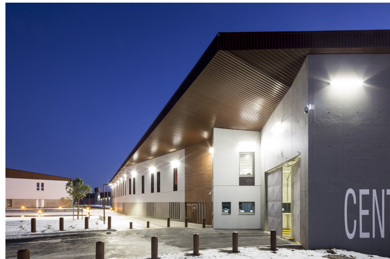
Le Centre pénitentiaire d'Aix-Luynes 2
