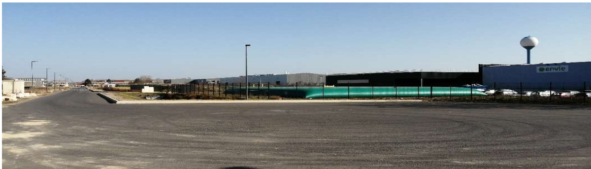
Vue 1 - Le site s'inscrit dans la zone industrielle Croix d'Argent, dont le château d'eau se perçoit grandement à l'échelle du paysage lointain.
