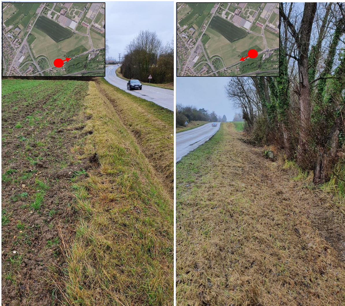
Figure 8: Talus situé entre la zone 2 et la voirie au sud
