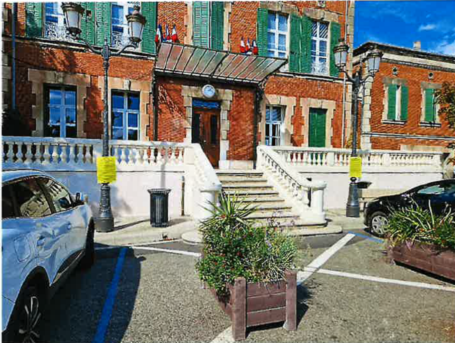
Direction départementale des Territoires – Avenue 7 ème Génie
