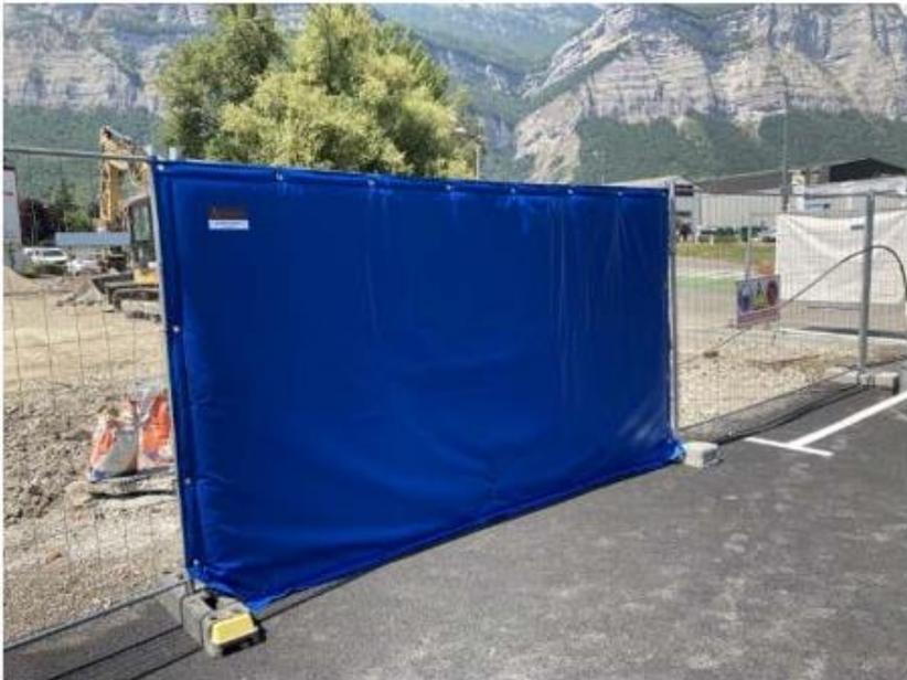
**FIGURE 15 : BARRIERES AVEC BACHES ACOUSTIQUES**
