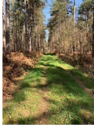
Tronçon 12 NB : les fossés se situent de part et d'autre du chemin sous les fougères
