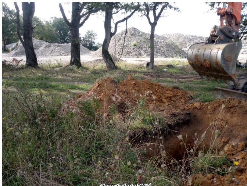
Vue générale PM14
