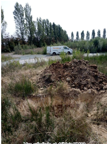
Vue générale et déblais PM22
