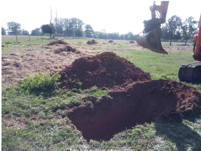
Vue générale et déblais PM17
