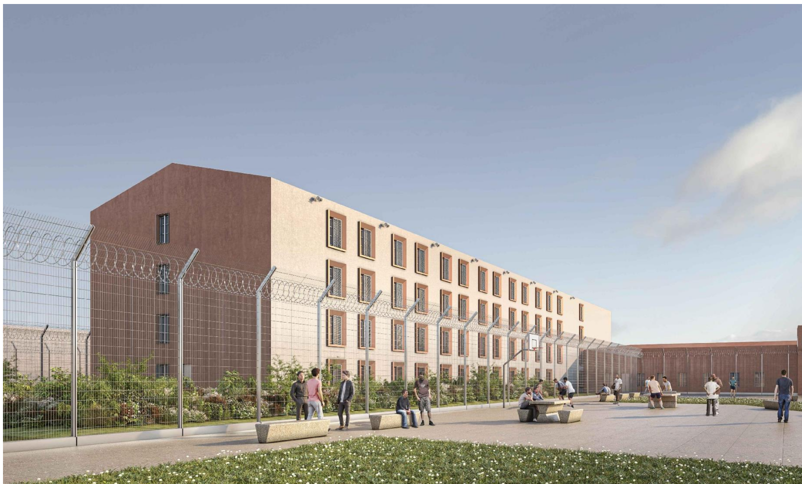
Perspective d'insertion du projet – vue depuis une cour de promenade (Source : Bouygues Construction, 2022)
