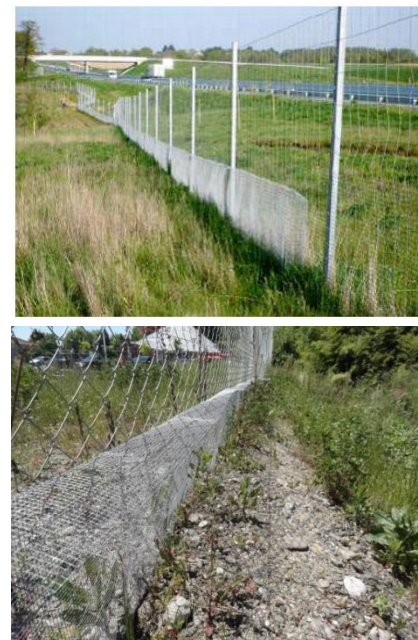
Figure 22 : Exemple de clôtures à mailles fines 5 mm x 5 mm
