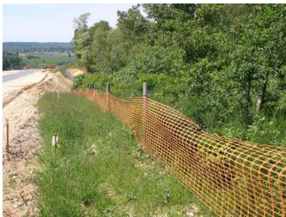
Figure 21 : Exemple de barrière de chantier (Source : Egis, 2015)
