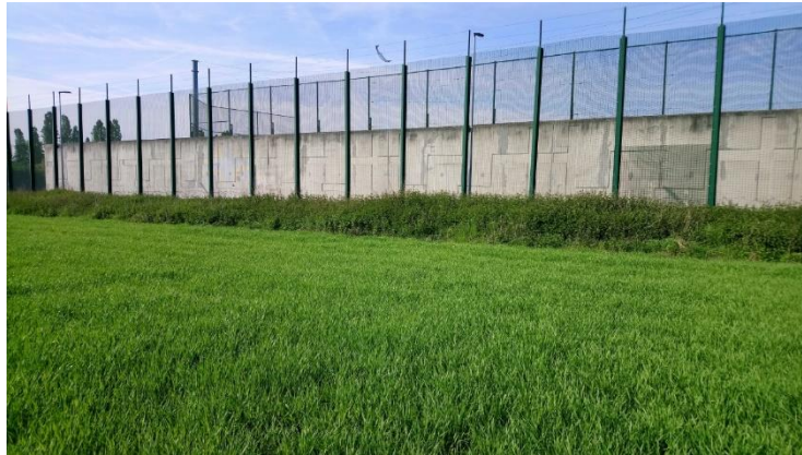
Figure 15 : Ourlet rudéral le long de la maison d'arrêt (Source : Egis, 2019)
