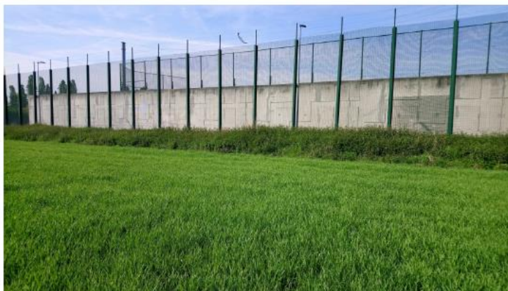
Photo 1 : Talus enherbé le long de la bordure de la maison d'arrêt
