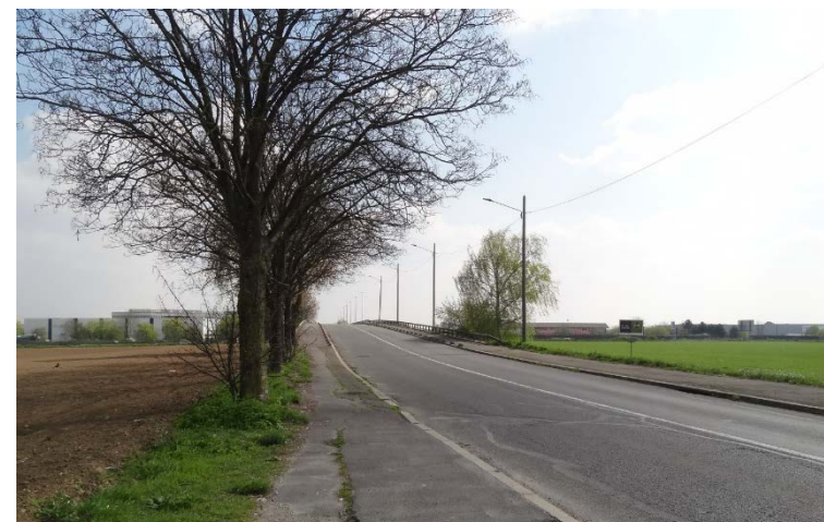
Ouvrage de franchissement de l'A104 permettant de relier le secteur nord au secteur sud de Tremblay-en-France (Source : Egis, avril 2019)
