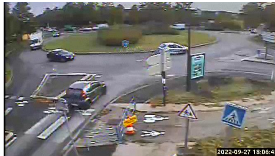
Vue du giratoire C1 depuis l'est : les remontées de files d'attente sur la D40 depuis C4 remontent (très ponctuellement) jusqu'au giratoire C1
