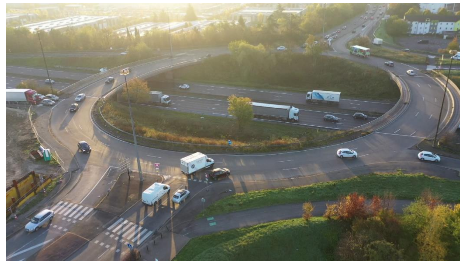
Vue depuis le nord-ouest du giratoire C4 : branche D40 Sud légèrement chargée
