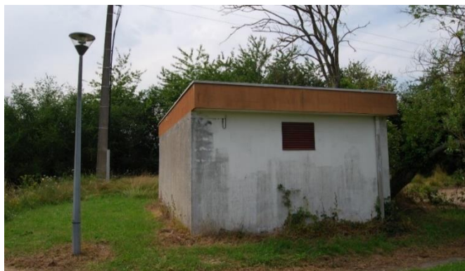
Figure 126 : Transformateur sur le site du Centre AFPA (Source : Egis, juillet 2021)
