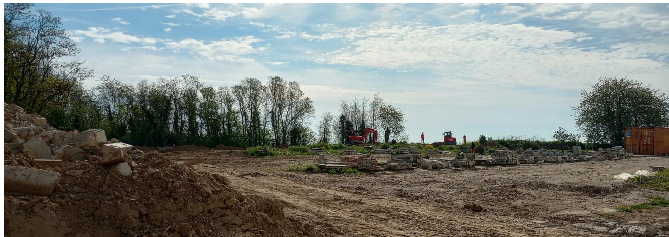
Figure 101 : Vue 6 proche : Un espace dédié aux formations BTP, toujours dans l'emprise projet. Le nord du site d'étude est en point haut par rapport au sud du site. (Source : Egis, mai 2023)
