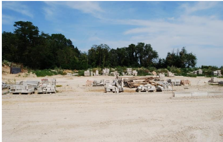
Figure 132 : Installations du Centre AFPA au premier plan, lisière boisée au second plan (Source : Egis, juillet 2021)
