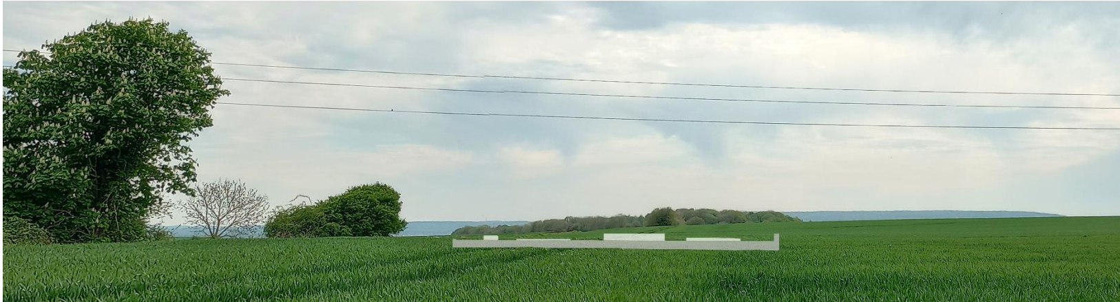
Figure 187 : Photomontage 4 : Etat projeté. Implantation du futur établissement pénitentiaire en transparence (sans plantation avec topographie plane) afin que montrer que le site n'est pas du tout perceptible depuis ce point de vue (source : Egis).
