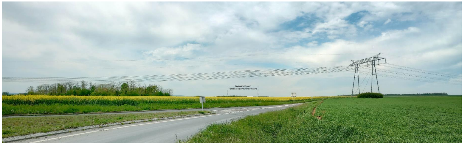
Figure 84 : Vue 06 – Vue prise depuis la départementale D118. Le boisement du site est perceptible Identifiée par le PNR comme point de vue/relation visuelle structurant. (Source : Egis, mai 2023)
