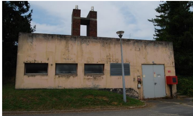
Figure 127 : Chaufferie au gaz du Centre AFPA (Source : Egis, juillet 2021)
