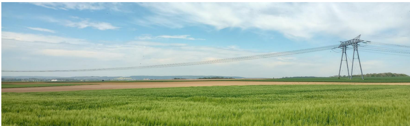
Vue 14 : Vue prise depuis le chemin de la Remise du Trèfle vers le site d'étude. Des covisibilités lointaines existent avec le site d'étude (Source : Egis, mai 2023)
