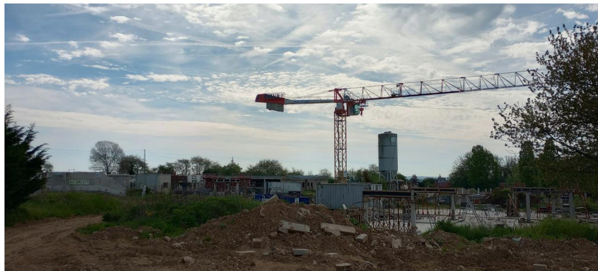
Vue 7 proche : Un espace dédié aux formations BTP, toujours dans l'emprise projet. Le nord du site d'étude est en point haut par rapport au sud du site. (Source : Egis, mai 2023)
