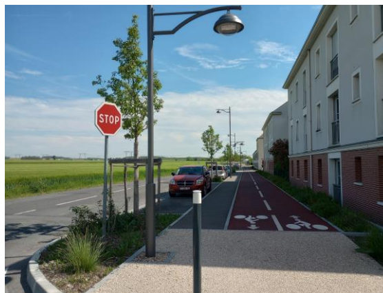
Vue 15 : Nouveaux petits collectifs et aménagements rue de Boran , à l'entrée de Bruyères-sur-Oise – (Source : Egis, mai 2023)
