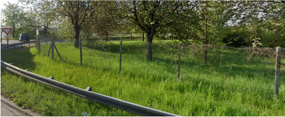
FIGURE 21 BASSIN AU DROIT DU GIRATOIRE DE LA RD924
