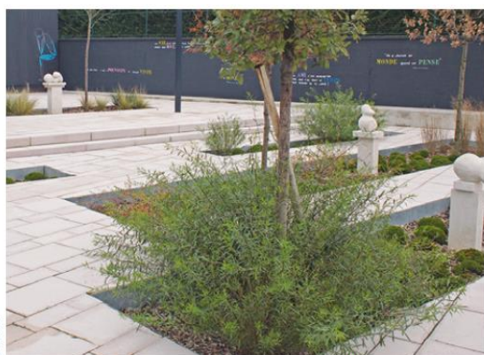
Fosse d'arbre décaissée et végétalisée, Romainville (93)
