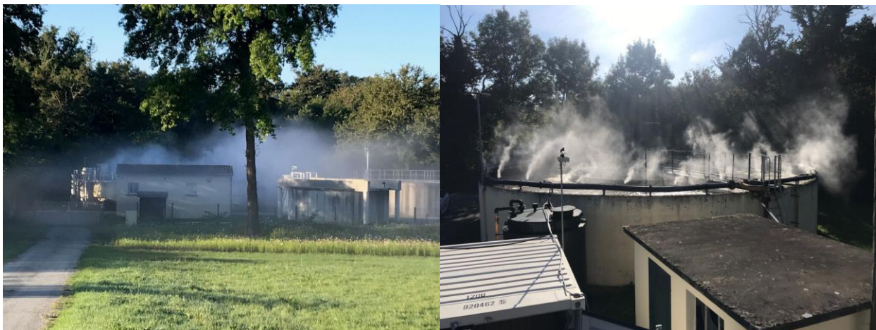
FIGURE 37 DISPOSITIF DE DESODORISATION PAR DIFFUSION
