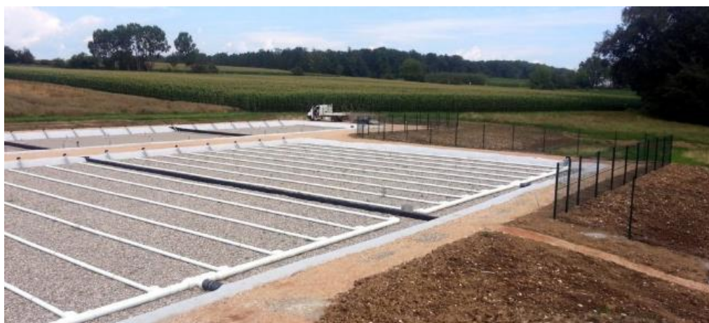
FIGURE 34 EXEMPLE DE FILTRE PLANTE DE ROSEAUX
