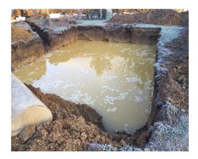
Construire une prison ici sur un site aussi humide, sablonneux, argileux en surface s'avère une réelle <u>contrainte technique et financière</u> (pieux <u>tubés...</u>, rabattement de nappes, aléas de coût, aléas sur la durée des travaux d'infrastructure etc..).
