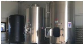
FIGURE 2 : CUVES DE TRAITEMENTS DES URINES
