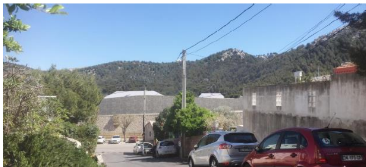
Figure 105 – Élévation ouest vue depuis le chemin de Morgiou
