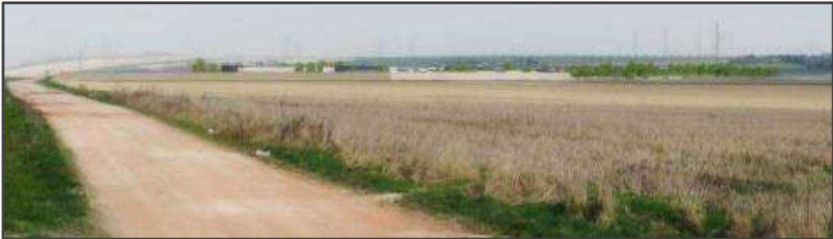
Photo après travaux.
