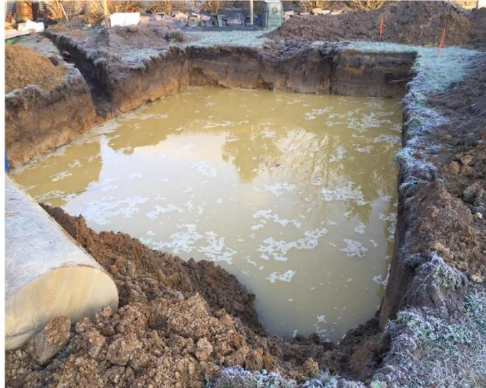
Construire une prison ici sur un site aussi humide, sablonneux, argileux en surface s'avère une réelle contrainte technique et financière (pieux tubés..., rabattement de nappes, aléas de coût, aléas sur la durée des travaux d'infrastructure etc..).
