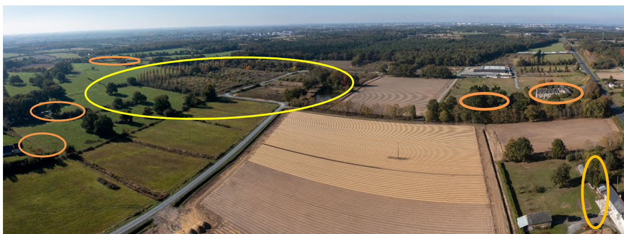
FIGURE 3 - VUE AÉRIENNE DE L'AIRE D'ÉTUDE (SOURCE : APIJ). EN ORANGE LES HABITATIONS VOISINES ET EN JAUNE L'AIRE D'ÉTUDE APPROXIMATIVE
