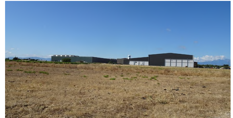
10 – Au sud, la Zone d'Activité du Mas de la Garrigue Nord marque le front urbain de Rivesaltes (Source : Egis, 2021)
