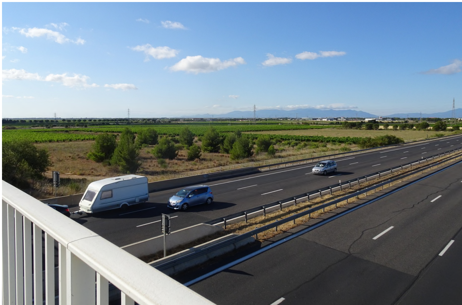
Etat actuel - Vue lointaine (n°2) sur le site, prise depuis le passage supérieur de l'A9 (RD12)
