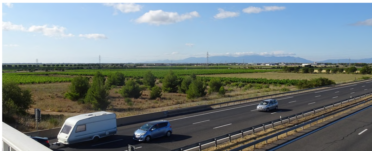
2 – Depuis l'autoroute, les automobilistes ont une vue dégagée sur le site (Source : Egis, 2021)
