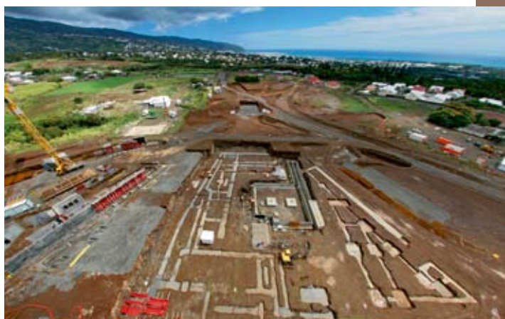
▲ Vue du chantier.
