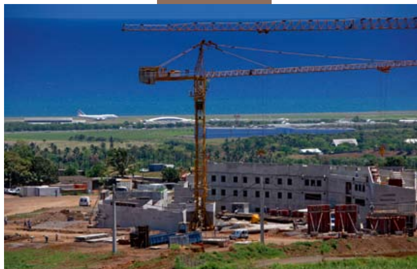
▲ Vues du chantier.
