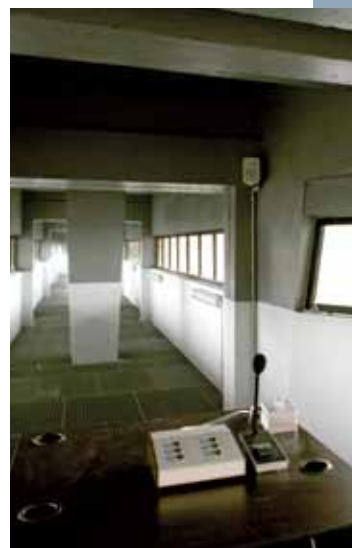
^ Vue intérieure de la passerelle de surveillance
