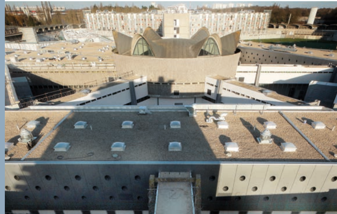
^ ^ Parloirs, greffe, zone d'accueil des visites, administration : les bâtiments centraux sont le centre névralgique de la maison d'arrêt.
