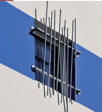
< ^ Un peu d'art en prison : l'architecte a choisi des couleurs vives et a dessiné les barreaux de protection des locaux administratifs en fagots.
