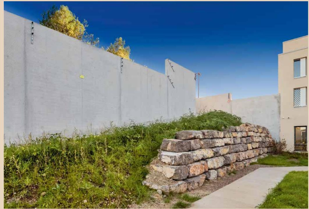
↑ Le mur d'enceinte, en béton matricé, est équipé de dispositifs de sécurité performants.
