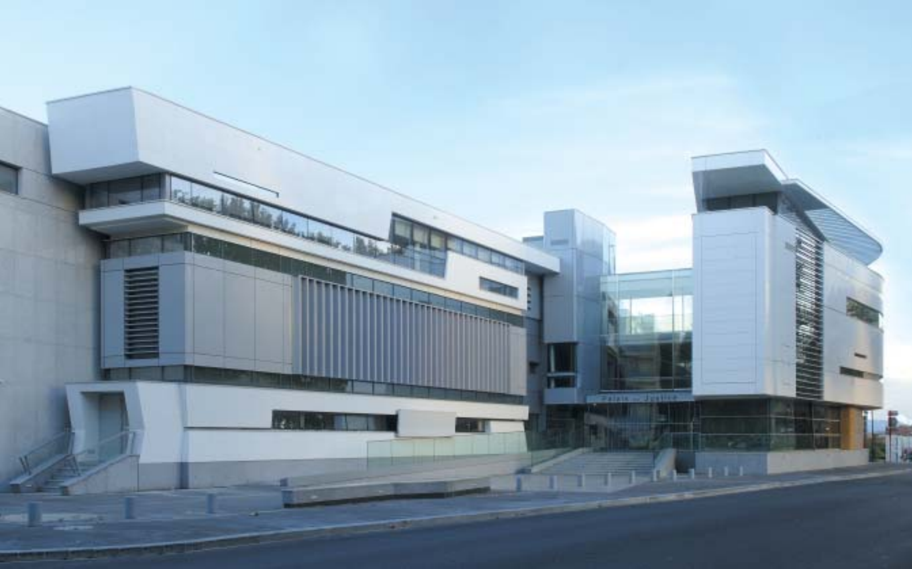
L'aile du tribunal de grande instance accompagne le parvis et ses brise-soleil verticaux évoquent la colonnade emblématique des bâtiments judiciaires classiques.
