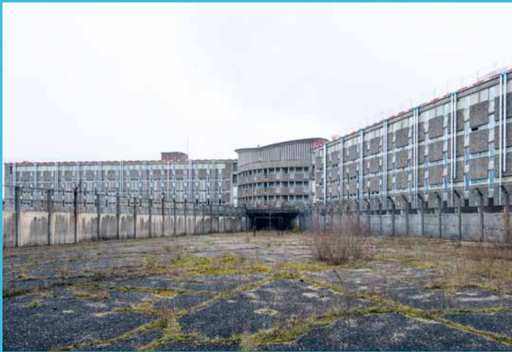
↑→ La rénovation des sols fait partie des travaux les plus visibles du projet de réhabilitation.
