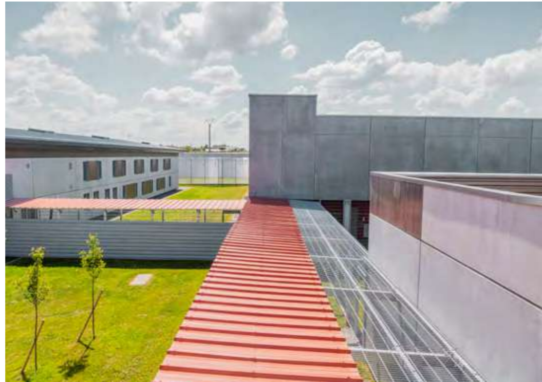
Centre pénitentiaire de Caen-Ifs
