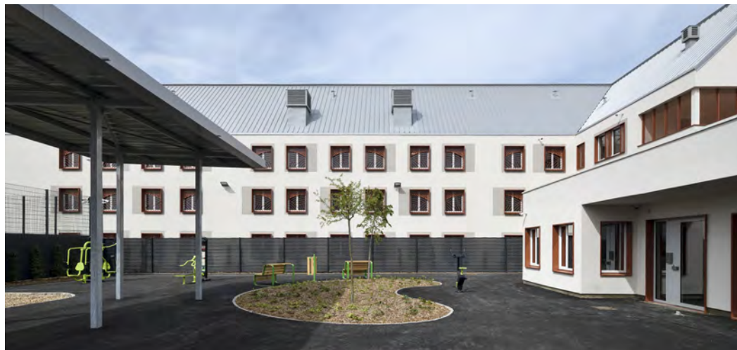
Structure d'accompagnement vers la sortie de Colmar
